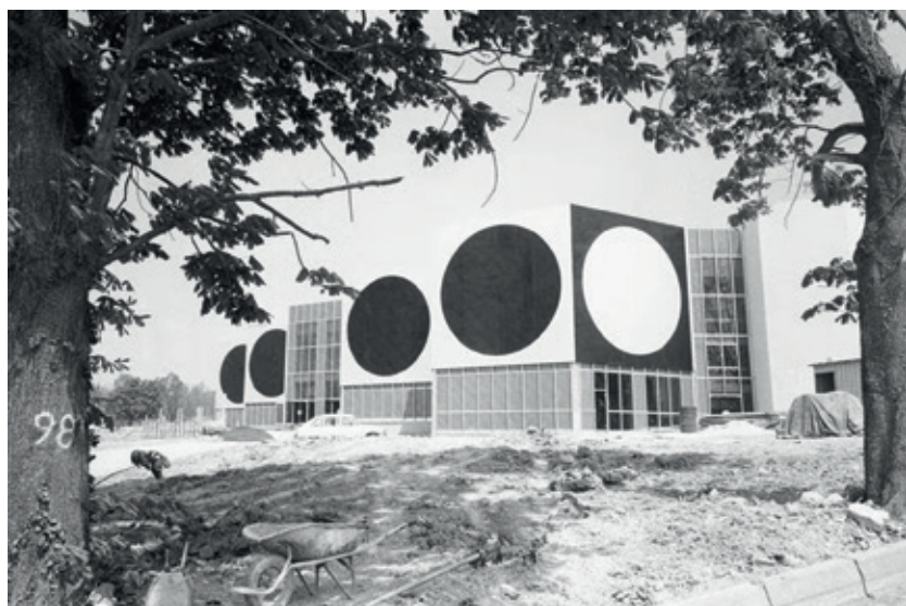
La Fondation Vasarely in costruzione, Aix-en-Provence, 1975
